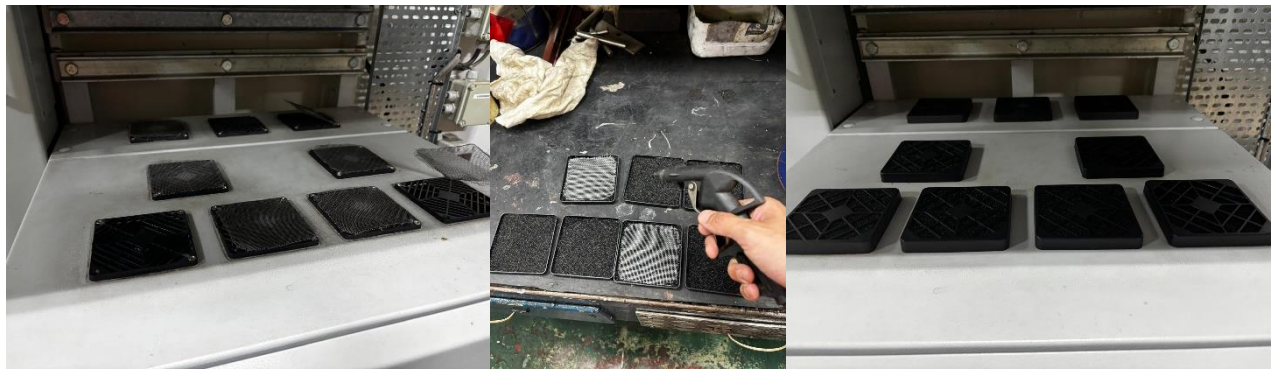
Figura 6. Limpieza de los ventiladores de la cabina de la DEU.
