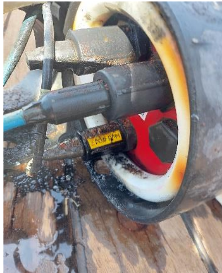
Estado del datalogger dañado.
