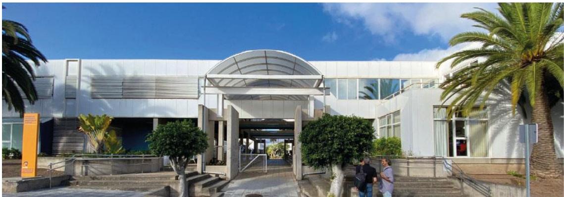
Campus de Ingeniería de la ULPGC, donde se encuentra el punto de calibración
