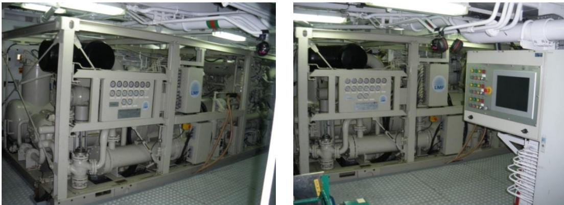
Figuras 5 y 6. Compresor LMF 25/138-207-E50 instalado a bordo del Sarmiento de Gamboa.
