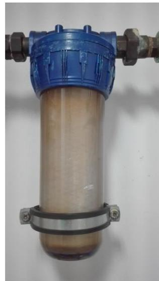
Antes de la parada en Faial se trabajo con el destilador de proa. Al salir de Faial se substituyo el prefiltro y se limpiaron las dos rejillas de entrada. Aprovechando el paron por las labores de mantenimiento se cambio el destilador de proa por el de popa, que ha estado trabajando sin incidencias hasta el final de la campaña.
