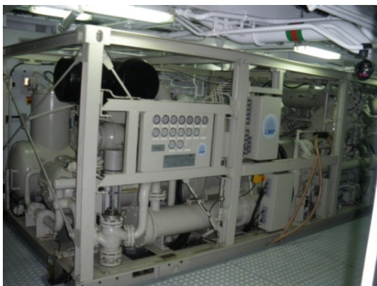
Figuras 2 y 3. Compresor LMF 25/138-207-E50 instalado a bordo del Sarmiento de Gamboa.
