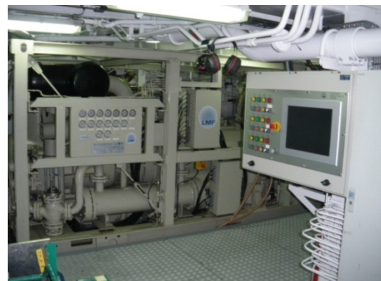
Figuras 2 y 3. Compresor LMF 25/138-207-E50 instalado a bordo del Sarmiento de Gamboa.
