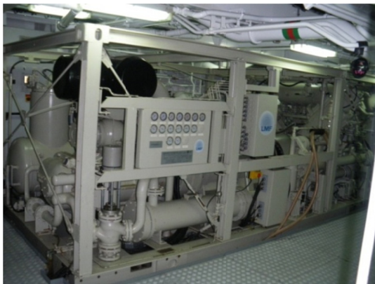
Fotos 6 y 7. Compresor LMF 25/138-207-E50 instalado a bordo del Sarmiento de Gamboa.
