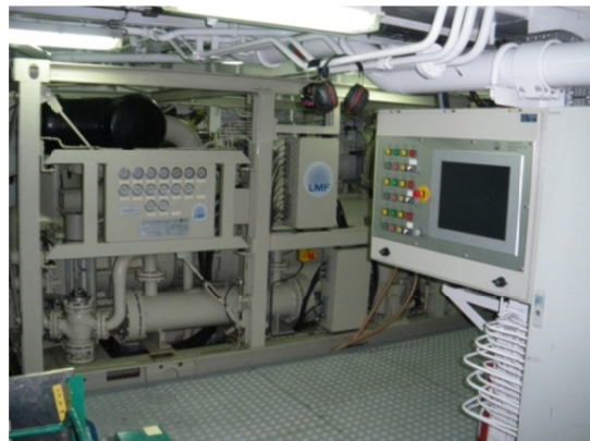
Fotos 6 y 7. Compresor LMF 25/138-207-E50 instalado a bordo del Sarmiento de Gamboa.
