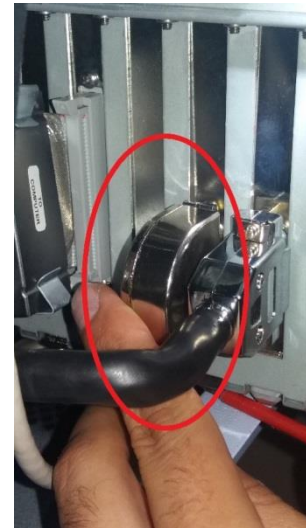
Conector al ordenador interno suelto
