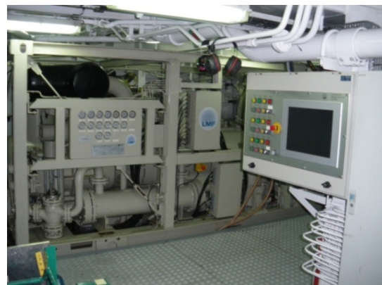
Fotos 5 y 6 . Compresor LMF 25/138-207-E50 instalado a bordo del Sarmiento de Gamboa.
