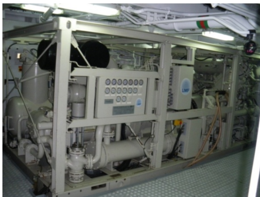
Fotos 5 y 6 . Compresor LMF 25/138-207-E50 instalado a bordo del Sarmiento de Gamboa.
