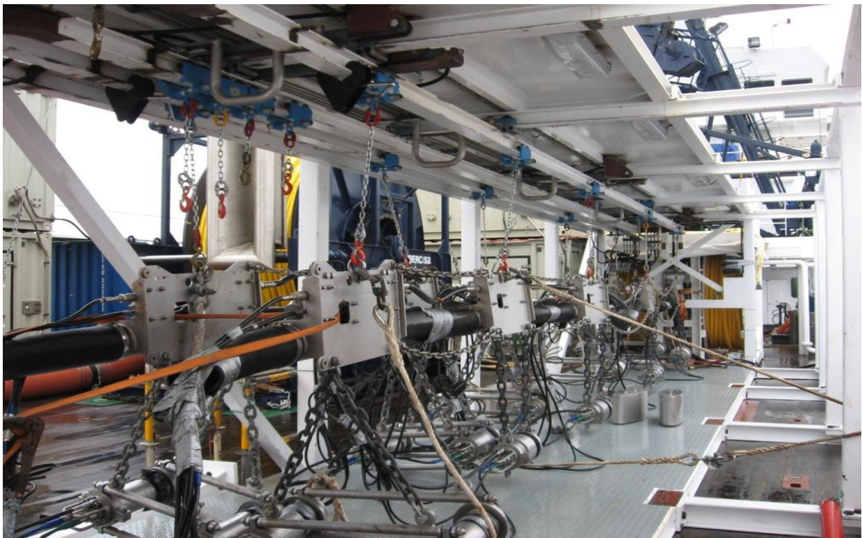
Foto 9. Estructura de cañones diseñada y fabricada por UTM.
