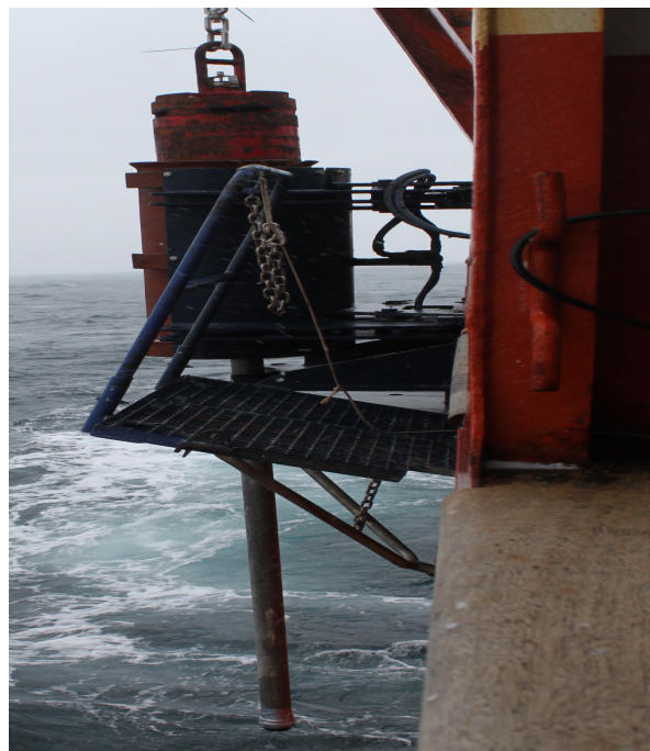
Foto 10 .Detalle instalación "gravity corer".
