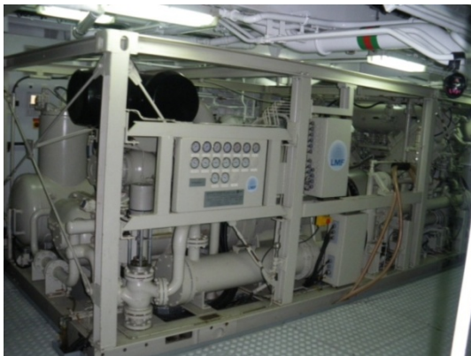
Fotos 4 y 5. Compresor LMF 25/138-207-E50 instalado a bordo del Sarmiento de Gamboa.
