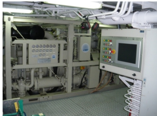
Fotos 4 y 5. Compresor LMF 25/138-207-E50 instalado a bordo del Sarmiento de Gamboa.
