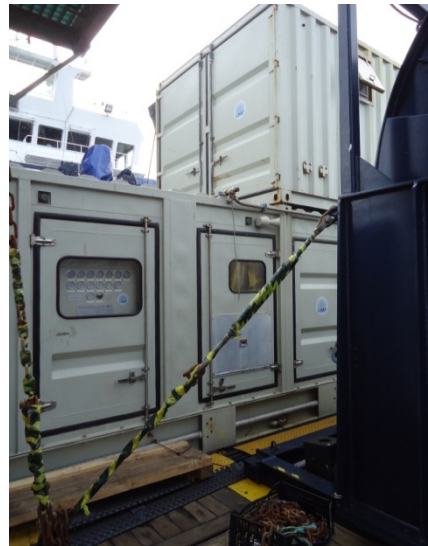
Fotos 2 y 3. Compresor LMF 25/138-207-E50 instalado en cubierta del Sarmiento de Gamboa.
