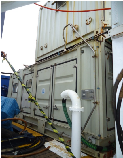
Fotos 2 y 3. Compresor LMF 25/138-207-E50 instalado en cubierta del Sarmiento de Gamboa.
