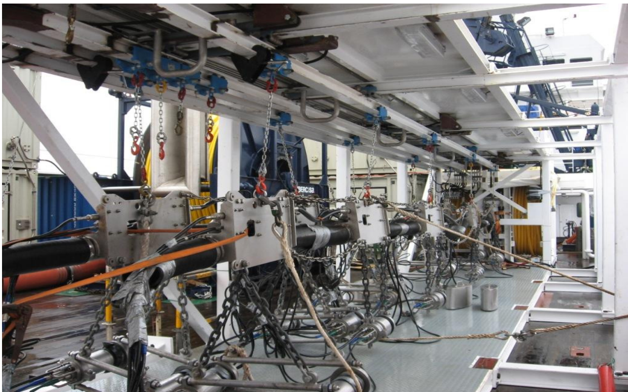
Foto 8. Estructura de cañones diseñada y fabricada por UTM.
