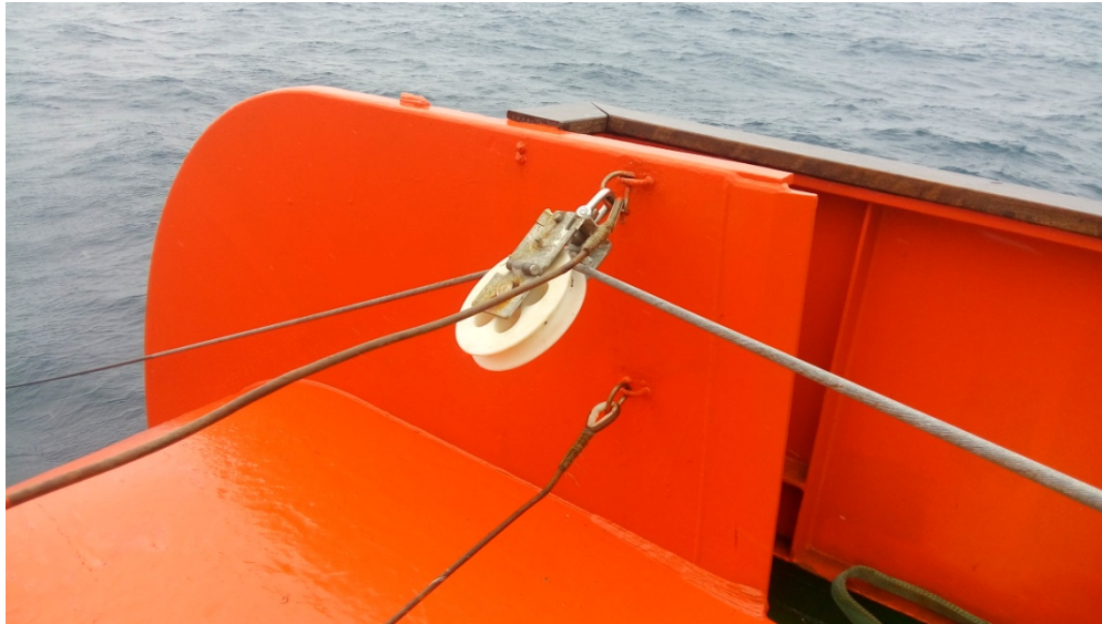
Foto 14. Imagen de la instalación del magnetómetro.
