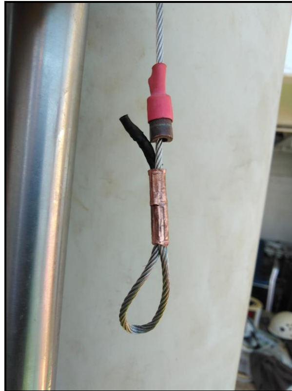
Fig 9. Reparación latiguillo MSC
