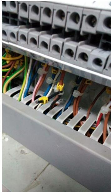
La borna nº5, es la correspondiente a la alarma del transductor de presión, se cortó el cable negro.
